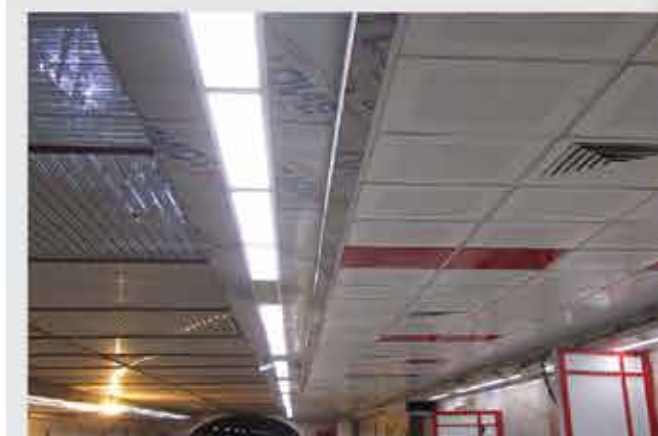
نام پروژه: ایستگاه متروی شهدا مساحت: ۶۰۰۰ متر مربع سال اجرا: ۱۳۹۵ نوع محصول: لوکسالون - ورق کامپوزیت - تایل آلومینیومی نمایان
