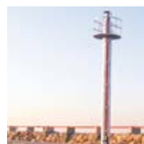
برج آتش نشانی / ۲۴
