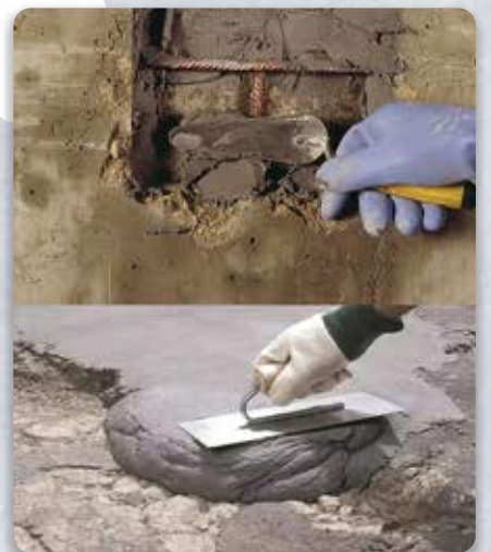
ترمیم سازه های بتنی
