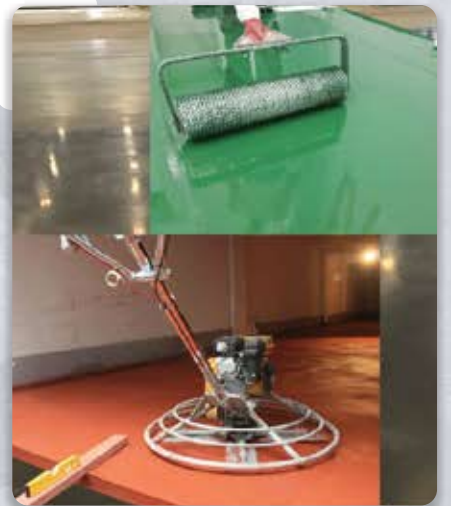
اجرای کف سازی و کفپوش های صنعتی
