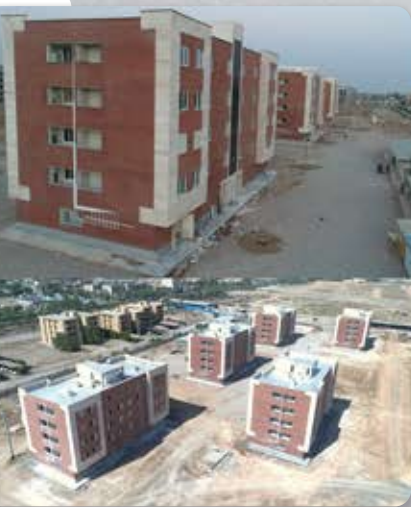
اجرای پروژه های ساختمانی و صنعتی
