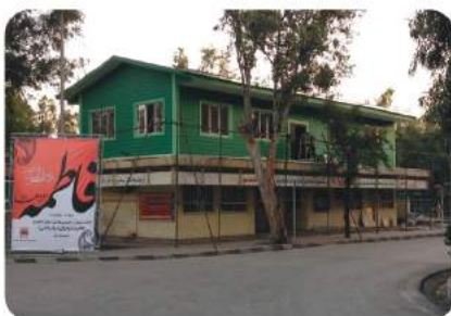
اضافه طبقه اداری / فولاد خوزستان
