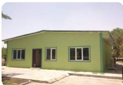
ساختمان اداری، کلید تحویل ۳۵ روزه / فولاد خوزستان
