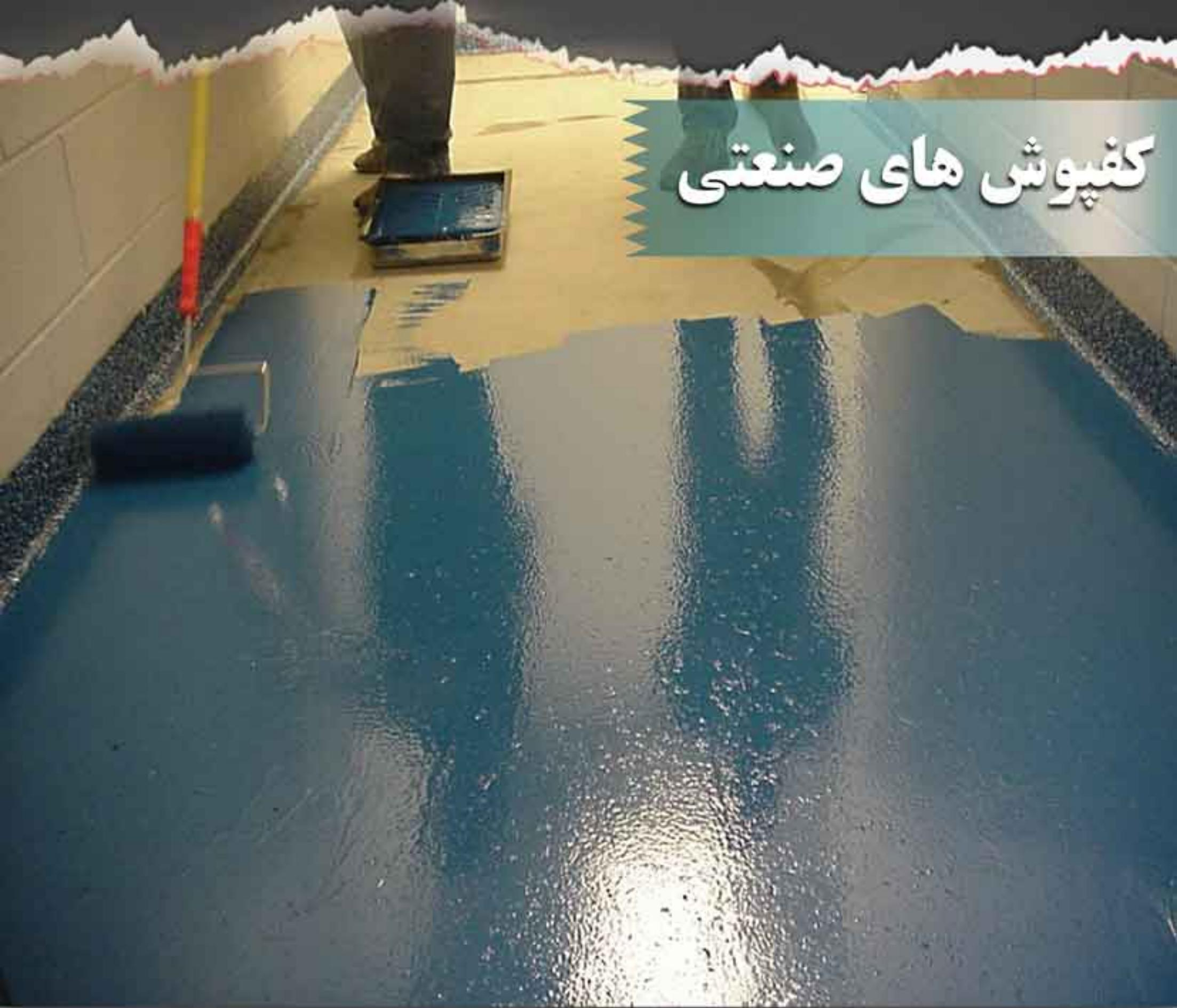
کفپوش های صنعتی شامل کفپوشهای اپوکسی ، پلی اورتان و کفپوش های گرانیتی میباشند که بدلیل ویژگیهای خاص ، تنوع رنگ ، طرح و بافت آن مورد استفاده صنایع و اماکن مختلف بویژه مکانهایی که تمیزی ، بهداشت و عدم وجود گرد و غبار مورد اهمیت است ، میباشند .
